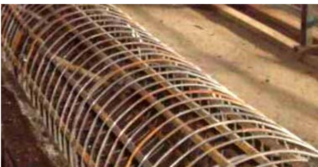
Рис. 1 – Металева арматура перед заповненням бетоном сумішшю
